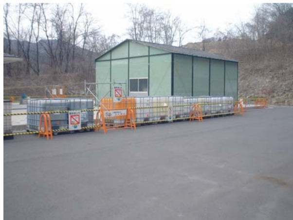
液肥プラント・液肥貯蔵タンク
