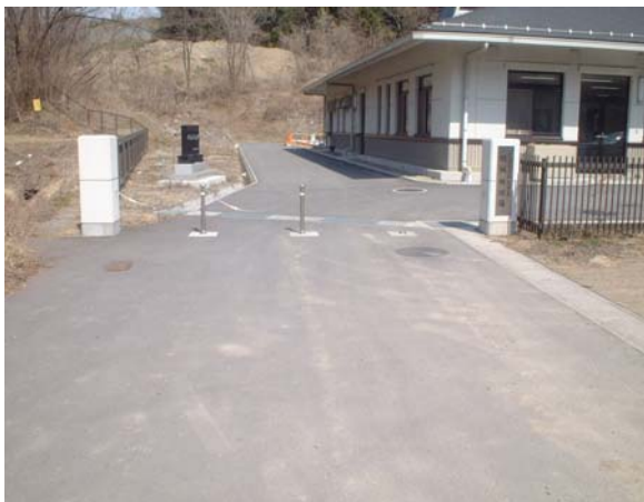
上田市殿城地区農業集落排水処理場入口
